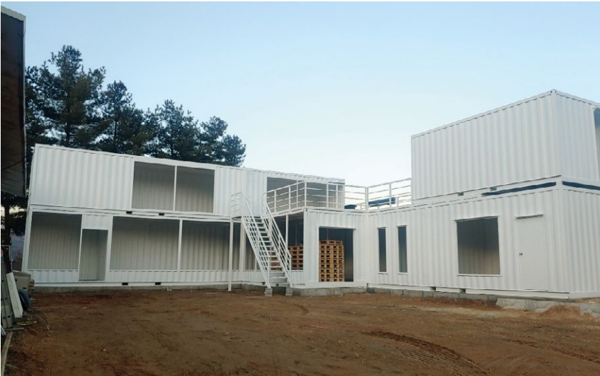
▽ 전시 부스 구조로 쓰였던 컨테이너를 해체한 후 약간의 보수를 거쳐 해비타트 목조 건축 교육장으로 재설치한 사진. 재조립에 대한 설계를 사전에 했기 때문에 하루 만에 이동 및 설치가 완료되었고 해비타트는 봉사단체라는 점에서 그 의미가 더욱 빛이 남 The entire booth was re-placed at the Habitat Wood-working Construction Education Ground after minor repairs. The moving and reinstallation only took one day due to prior planning. The fact that Habitat is a charity organization strengthened the underlying thought.
